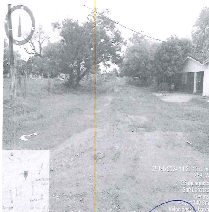
Calle de Tierra, durante lluvias no se puede circular dentro de la zona debido al ablandamiento causado por las infiltraciones de agua a las capas de suelo
