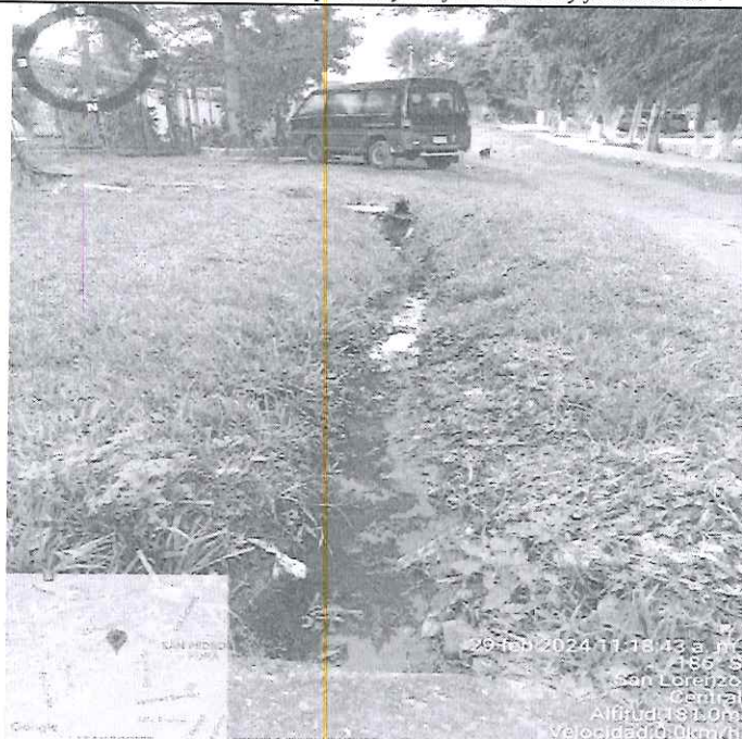
Cuneta formada debido al vertido de aguas grises dentro de la zona que erosionan el suelo alrededor
