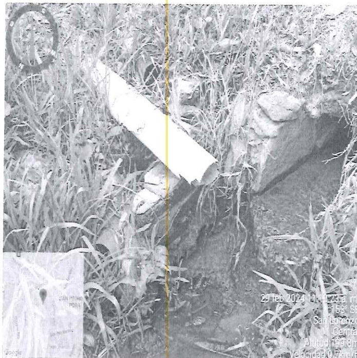
Distribución Final de aguas grises por parte de usuarios de la zona, en cuneta a casi nivel de vereda. Las aguas grises propician ambiente ideal para proliferación de bacterias y criaderos de mosquitos
