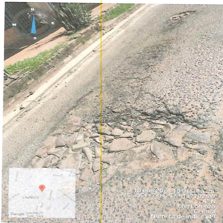
Deterioro Capa Asfáltica y Base de asiento Calle San Roque
