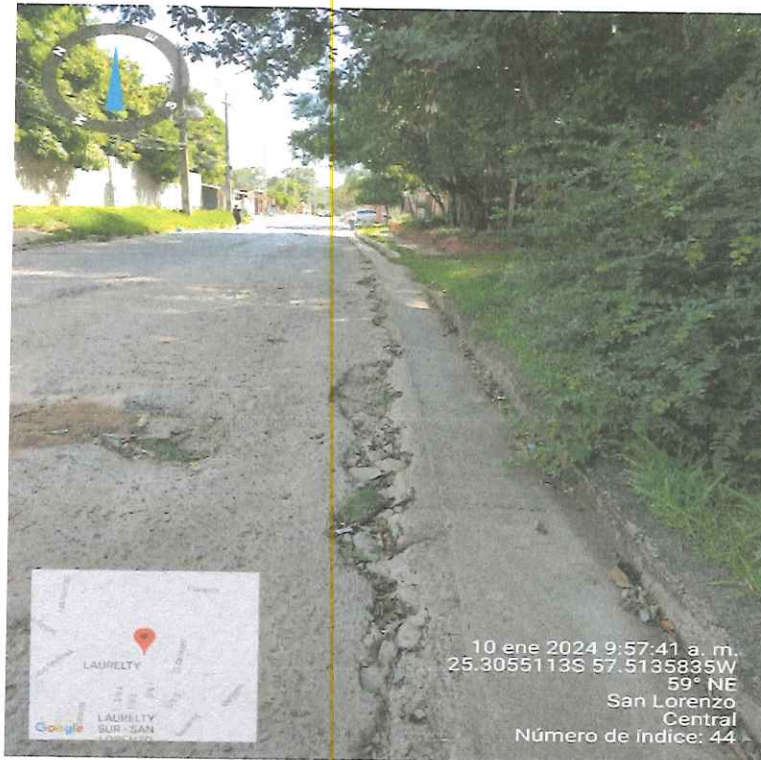
Deterioro Capa Asfáltica, base y cuneta Calle San Roque
