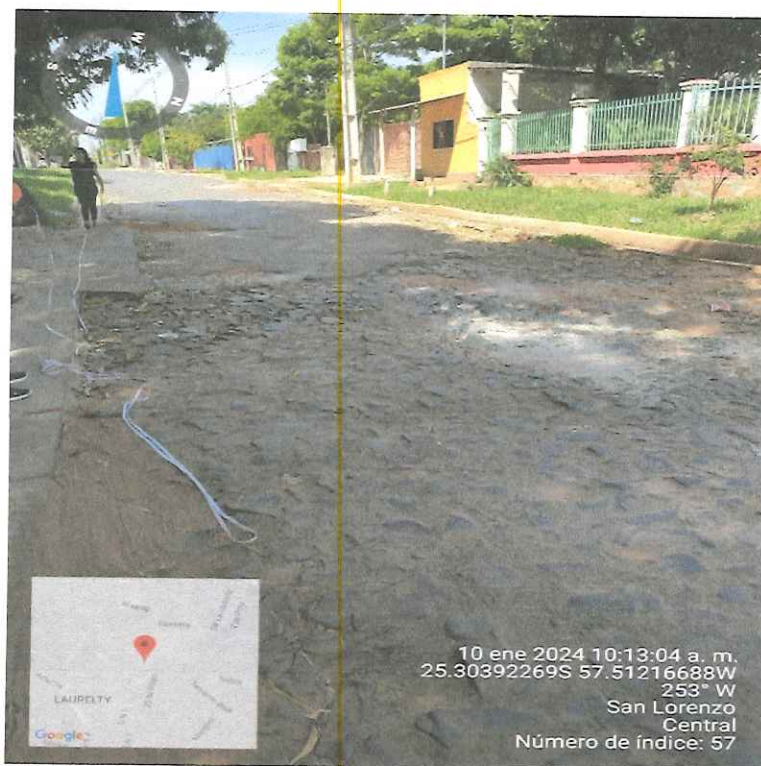
Dstrucción Progresiva de Capa Asfáltica y Base de empedrados Calle San Roque
