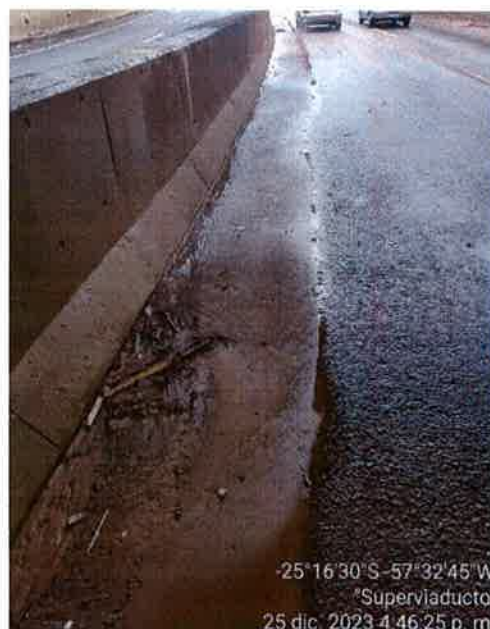
(Registro obstruido por el exceso de arena y basura)
